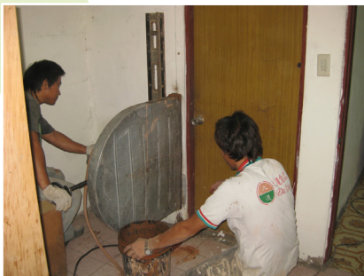
設施設備的修繕－修改房間門寬度。
